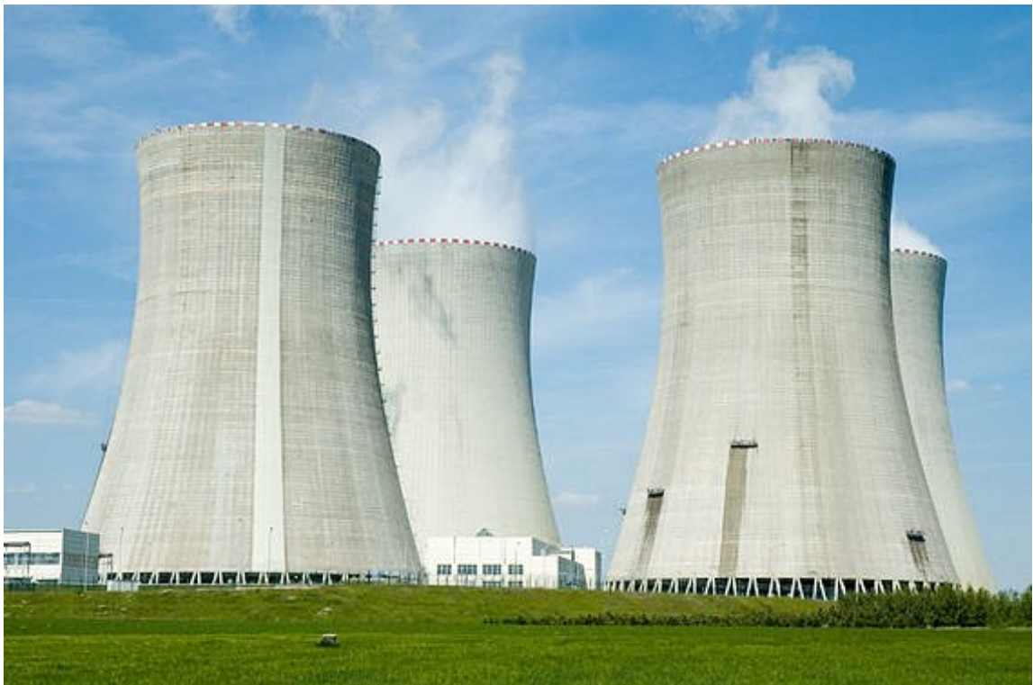
Figura 1: Torre de refrigeración típica
